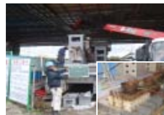
写真-2 ジャッキアップ
