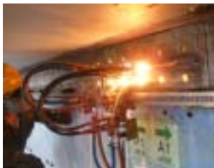
写真-3 主桁ウェブ切断
