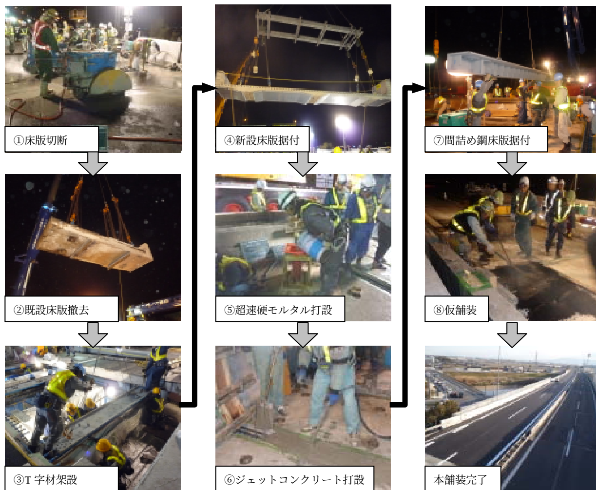
写真-5 集中工事施工状況
