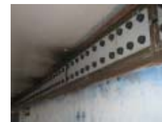
写真-4 主桁ウェブ仮添接
