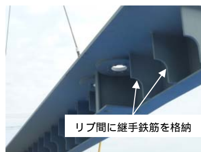
写真-1 間詰め鋼床版
