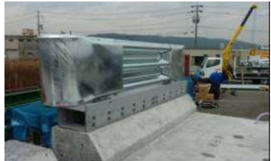
写真-1 仮設防護柵
