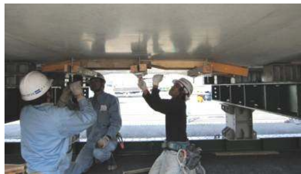
写真-4 配筋・型枠作業の事前訓練
