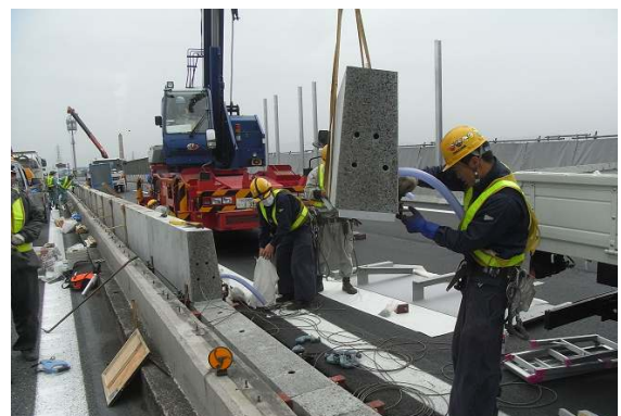
写真-2 プレキャスト高欄の施工状況
