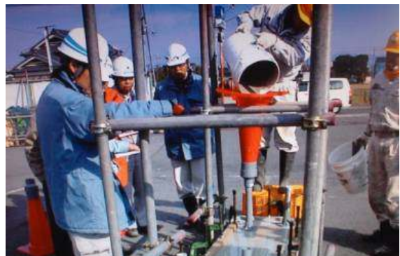
写真-3 超速硬無収縮モルタルの充填作業訓練
