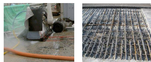
(1) WJ 施工状況
