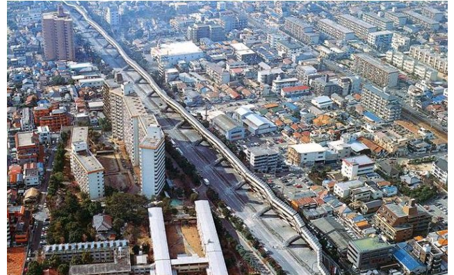
図-1 阪神高速3号神戸線の倒壊
