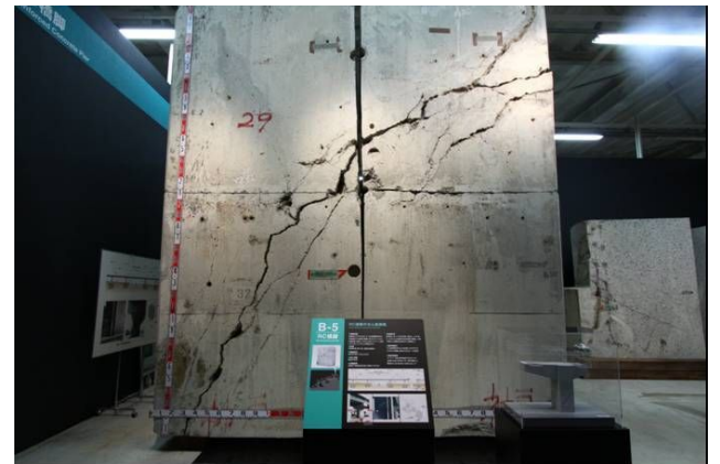
図-2 損傷構造物の展示状況 (コンクリート橋脚のせん断破壊)
