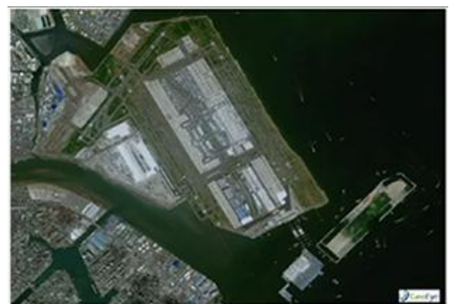
図 8 D滑走路現況写真(GeoEye-1)
