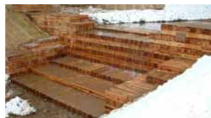
写真1 オールウッド型木製治山ダム
