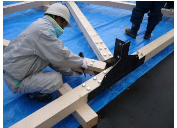
写真-3 手作業による組立て
