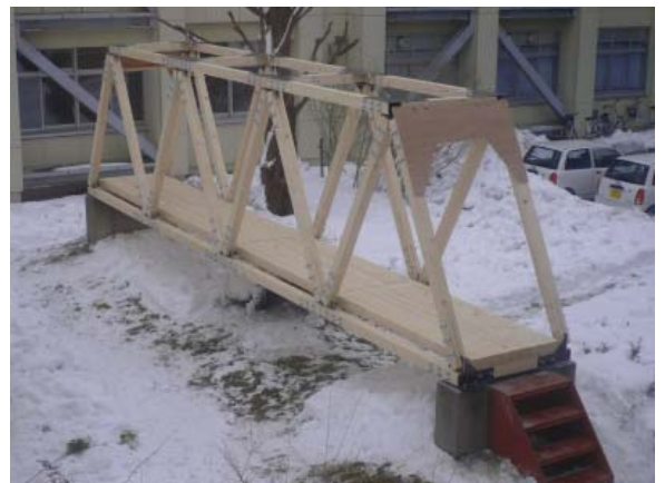
写真-4 トラス橋全景
