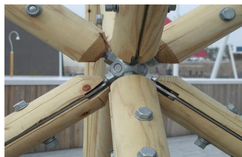
図-3 ボールジョイント接合部
