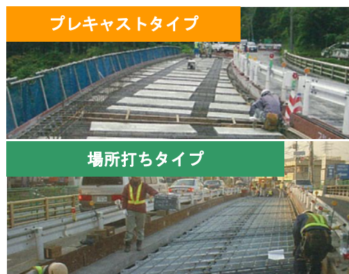
写真 1 本合成床版による床版取替えの例
