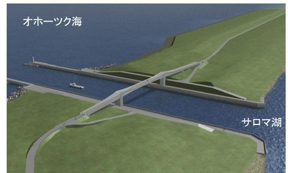
図-2 完成予想図(航路幅 75m, 桁下高+14.0m)
