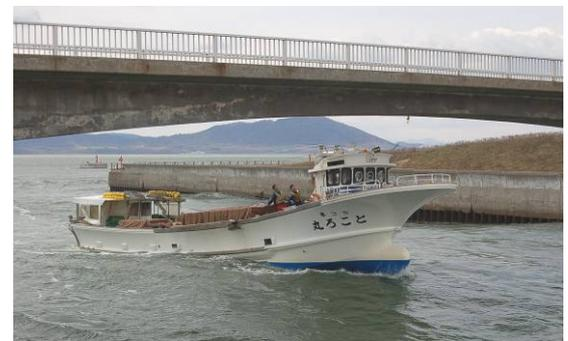
写真-2 既設橋梁の状況(桁下高+7.1m)
