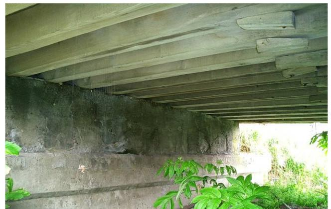
写真-2 構造は矩形に製材された木桁を並べた単純のもの。しかし、無筋コンクリート床版との接合面に秘密がある。
