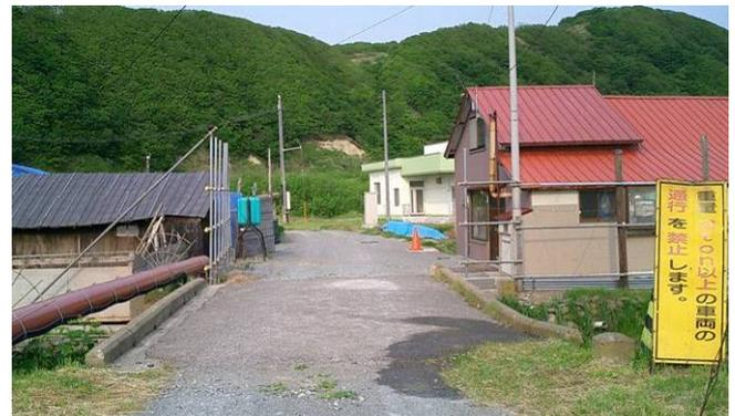
写真-1 橋長 6.0m, 幅員 4.0m の木コンクリート橋（柏谷橋）。旧道道だった路線で昭和 18 年頃に建設された。この技術の開発初期の姿を今に伝える貴重な土木遺産である。
