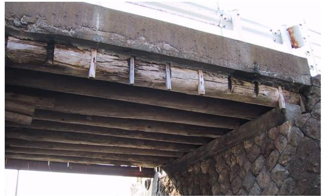
写真-3 戦後は研究が進み、上面だけを製材した丸太材を使って経済性を追求した。この技術の究極の姿(雨竜川橋)。
