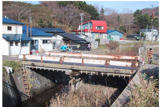
写真-4 2@5.0m, 幅員4.0mの木コンクリート橋(荒谷橋)。2級国道228号だったところで昭和40年代始めに建設され、平成13年まで車が通っていたという。側面の栈木には雨掛かりを避けるためにトタン板が打ち付けられていた。
