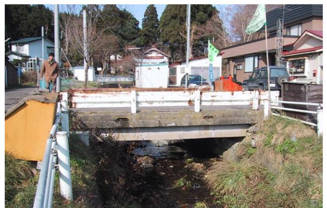
写真-5 4.8m, 幅員4.0mの木コンクリート橋(鳥井橋)。こも旧2級国道228号。現役の橋梁でトラックも通過する。側面には真新しいトタン板が打ち付けられ、非常に状態がいい。
