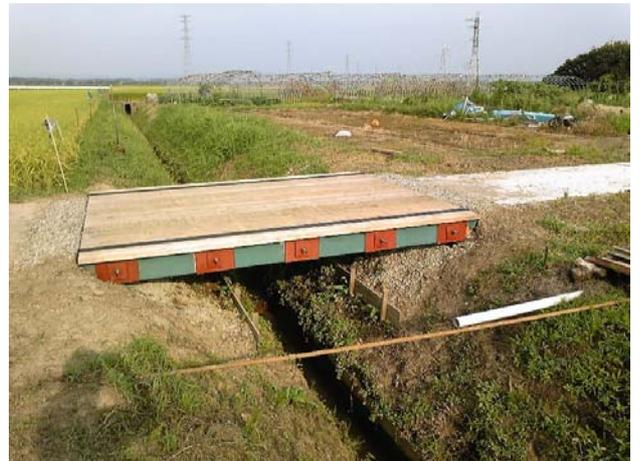
写真-1 プレストレス木床版橋(新潟県上越市)
