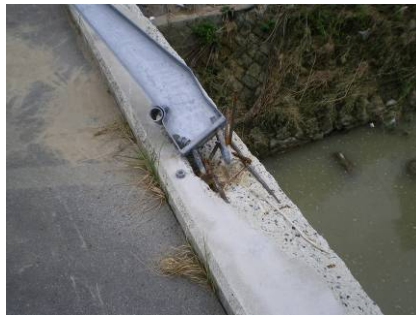
図-8 佐用町・笹ヶ丘橋ノ全景 図-9 欄干が取付部から剥がれた状況 図-10 橋桁への流木載り越し防止装置
