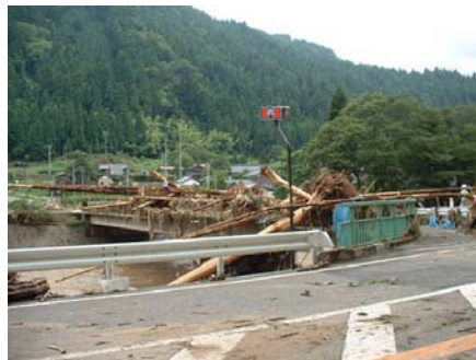
図-9 福井水害において流水・流木に耐えたコンクリート桁
