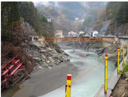
図-8 宮崎水害において流出した合成桁
