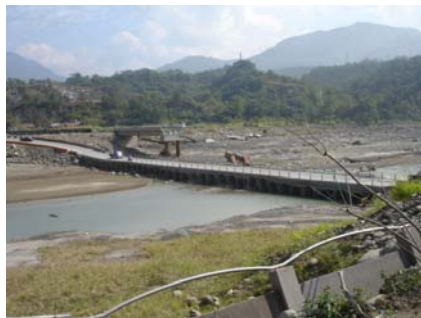
写真-7 コンクリート桁の流出 写真-8 鋼管杭製橋脚の座屈状況 写真-9 洗掘等により倒壊した橋梁
