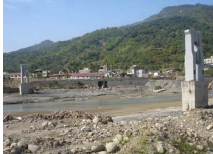
写真-4 狭窄部で中央径間のみが流出 写真-5 桁のみが破壊された吊り橋 写真-6 取付け部が破壊された橋
