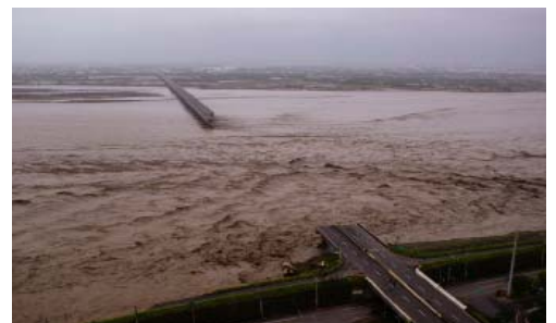
写真-7 コンクリート桁の流出 写真-8 鋼管杭製橋脚の座屈状況 写真-9 洗掘等により倒壊した橋梁
