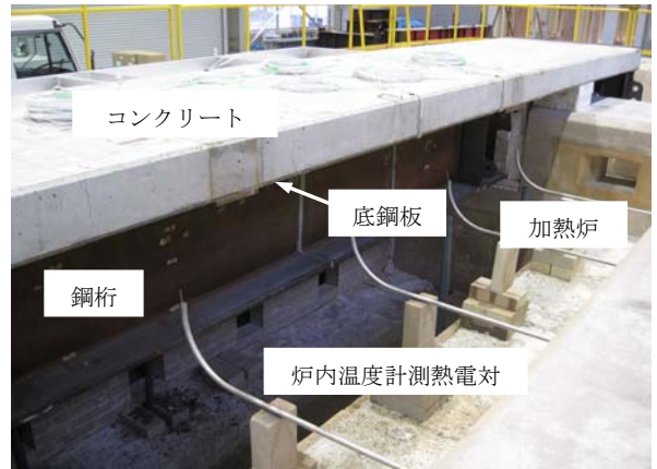
写真-1 実験供試体の設置状況
