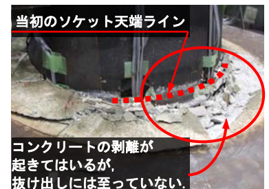
図-6 試験体 No. 1 6δy 損傷状況 (埋め込み長 2.0D, 定着長 33φ)
