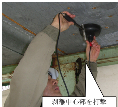
図-5 底鋼板の打撃状況
