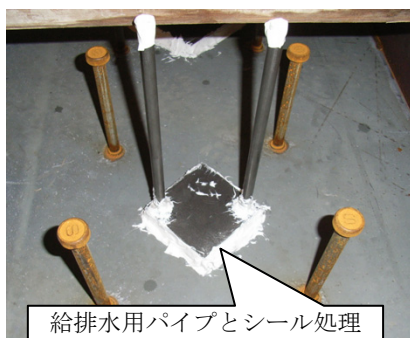
図-2 剥離間隙部のシール処理
