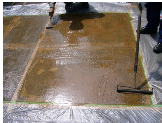
写真-2 施工試験の状況
