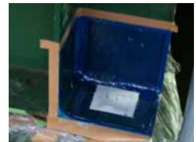
図-2 CFRP シート補修
