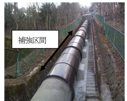
図-4 仕上がり状況
