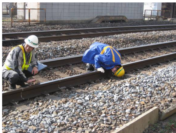
写真4 施工後の仕上り確認
