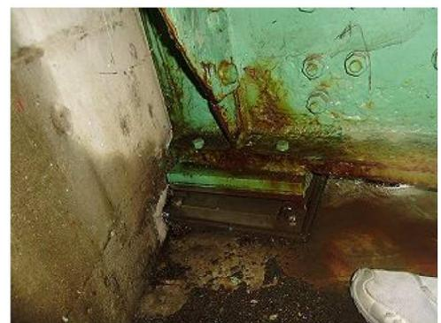
図-1 鋼桁支承部の劣化
