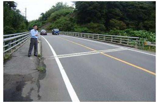
図-2 路面の滞水状況
