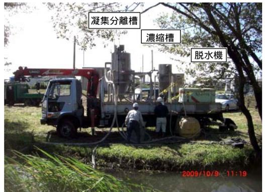
写真1 トラック積載型浚渫システム外観
