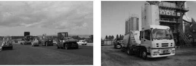
写真-4 施工状況 写真-5 ローリー車による運搬供給
