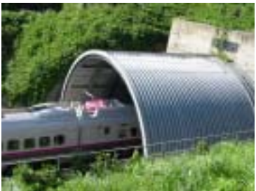
図1 トンネル緩衝工
