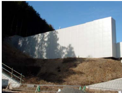
写真1 仮設防音パネル
