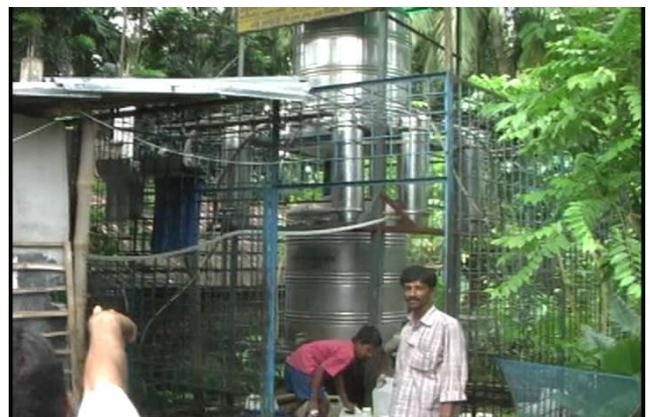
写真-3 砂濾過と砒素フィルターの付いた装置
