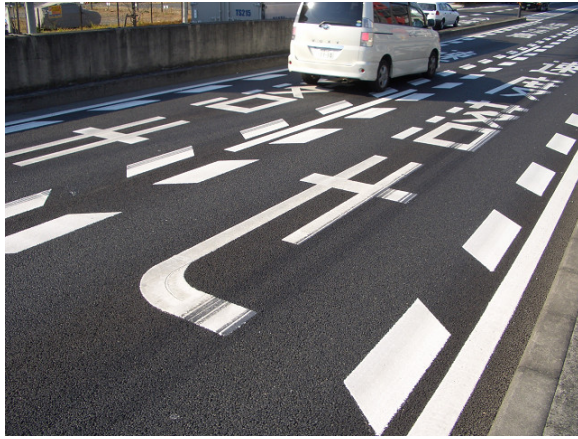
図-3 No.3 付近道路状況
