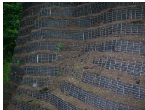
図1 階段植生工の状況
