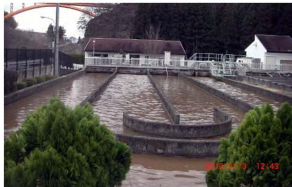
写真1 湯宿特環下水処理施設(縦軸OD法)外観
