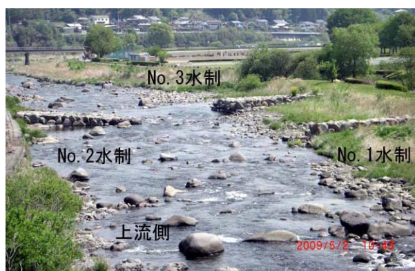
写真1 上流から眺めた3基の水制工
