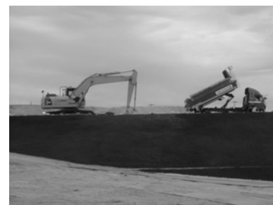
写真 掘削土(ズリ)置場搬出状況
