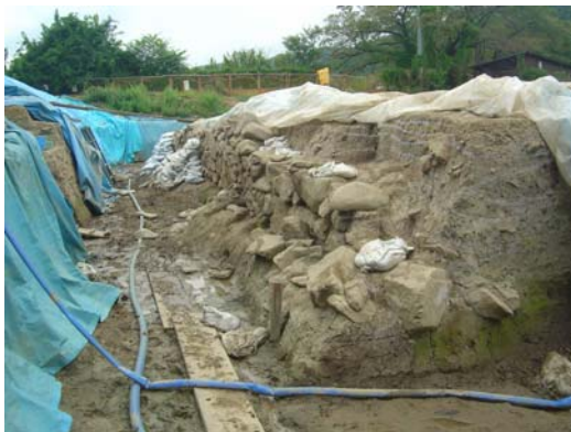
写真-1 石垣の全体状況（深掘りトレンチA）
