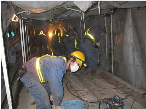
写真－２ 作業状況
