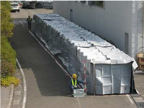
写真－１ 防音シート
