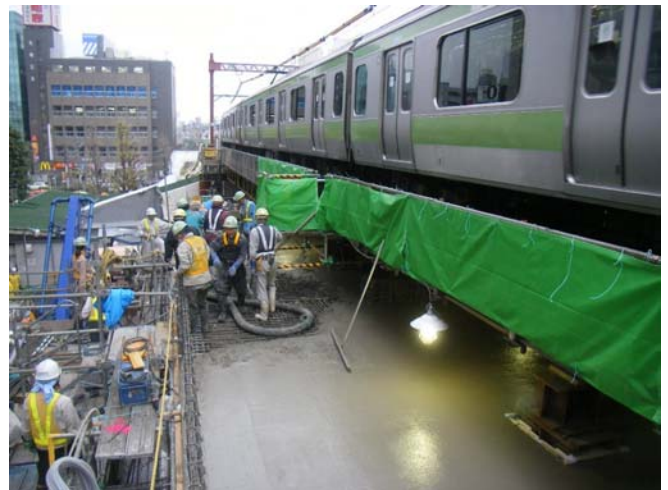
図-5 スラブコンクリート打込み(昼間施工)の状況
