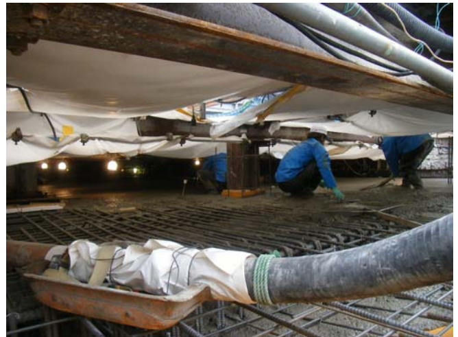
図-4 低空頭下でのスラブコンクリート打込み状況
