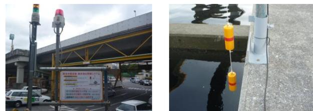
(a) 警報器とポスターの設置状況 (b) フロートスイッチの設置状況
