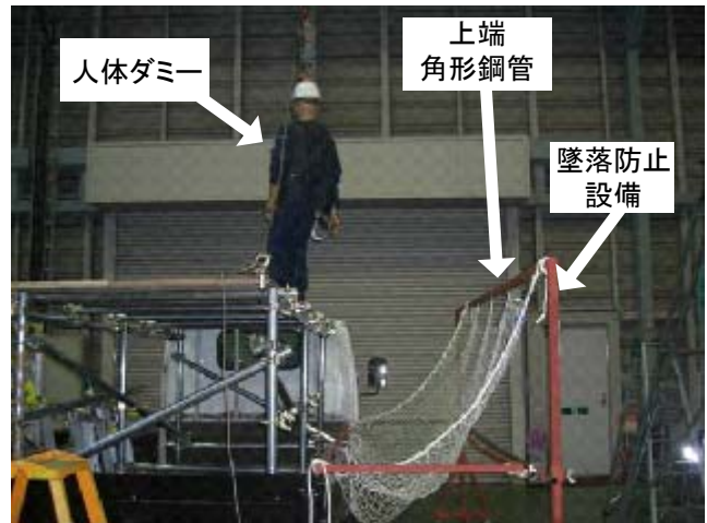
写真3 安全ネットによる荷主庭先据置型の墜落防止設備
