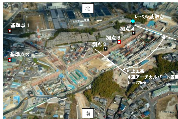
写真-1 打上工事開削工法区間
