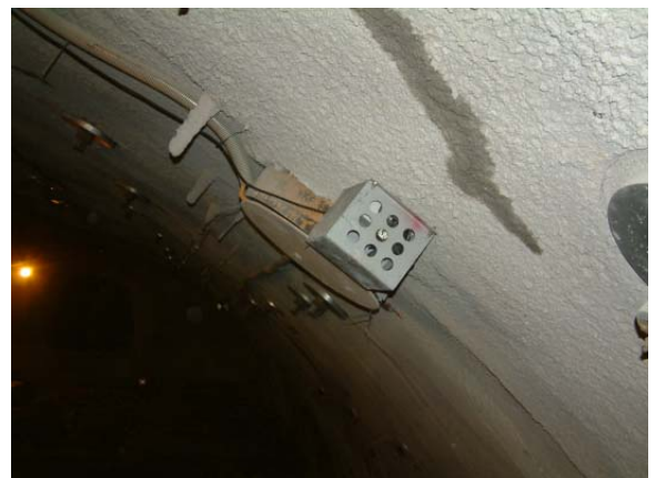
写真-1 発破防護取付け状況
