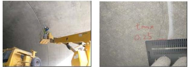
図-1 従来のひび割れ計測状況
