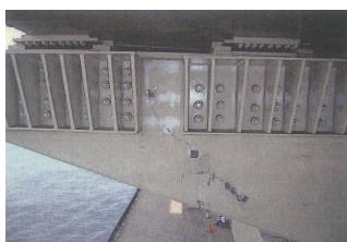
写真-1 郊外側梁側面
