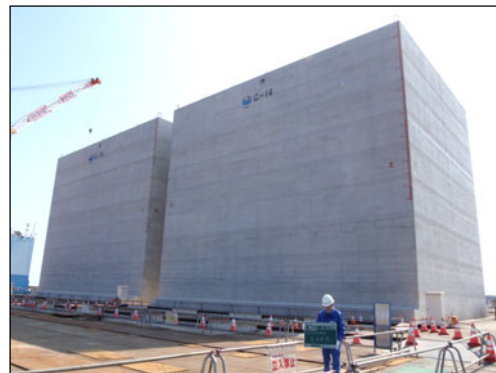
写真-1 常陸那珂港東防波堤本体ケーソン
