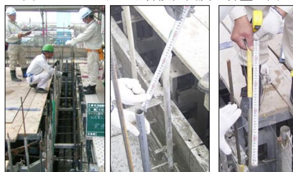
写真-3 N式貫入試験実施状況
