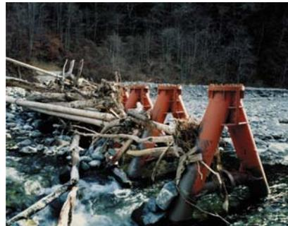
写真-1 根付き流木の捕捉事例
