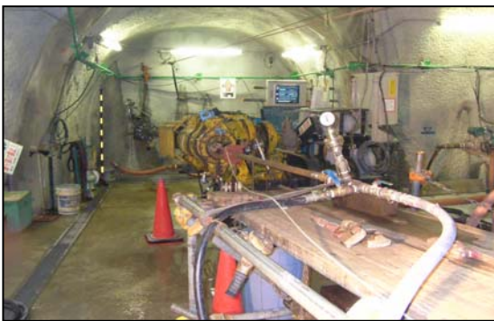
図-2 動的グラウト注入状況
