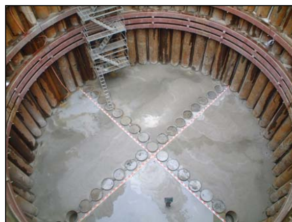
写真-4 鋼管矢板 掘削完了状況
