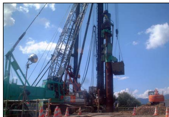
写真-3 鋼管の中掘り・圧入状況
