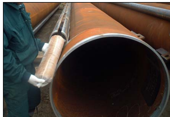
写真-2 充填材の設置
