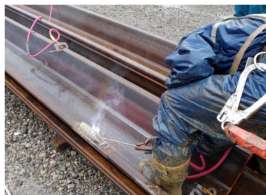
写真一2 先端装置取付(試験施工)
