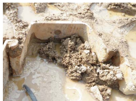
写真一3 注入管送水状況(試験施工)
