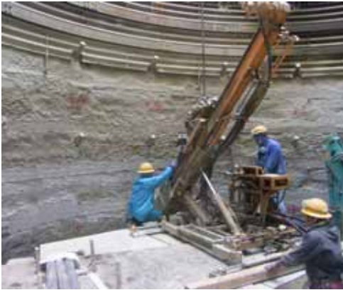
写真 - 1 G R F 補強材削孔状況
