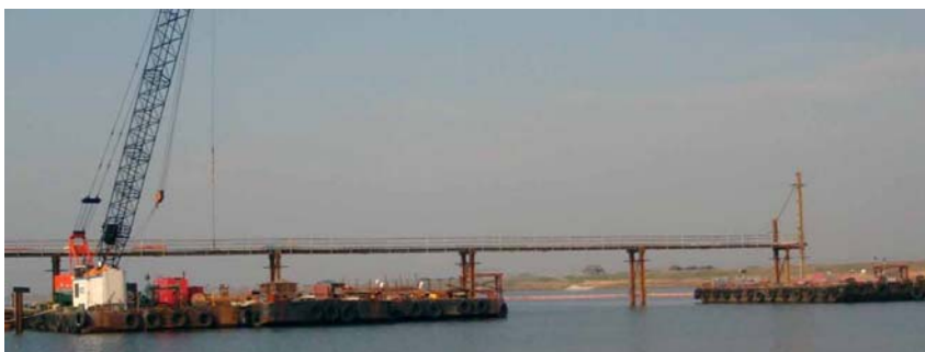
写真-3 コンクリート配管栈橋
